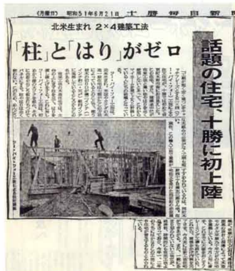
昭和51年道東で初となる2X4工法住宅を伝える新聞記事とその工事の様。施工は赤坂建設
